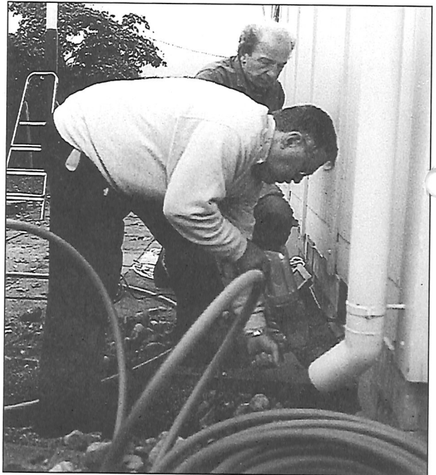
Die Stromer fädeln ein Behend Rohre und Kabel auf dem SG Gelände
